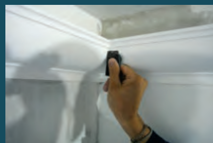
10. Зачистите место стыка наждачной бумагой и зашпаклюйте дырки от гвоздиков и степлера
