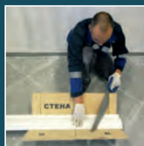
Монтаж лепного декора
