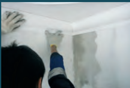
6. Прижмите изделие к стене и в сторону стыка со следующим изделием. Шпателем снимите излишки монтажного клея. Излишки стыковочного клея оставьте на месте стыка до полного высыхания, но не менее чем на 24 часа
