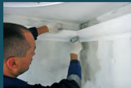
7. Место стыка зафиксируйте строительным степлером
